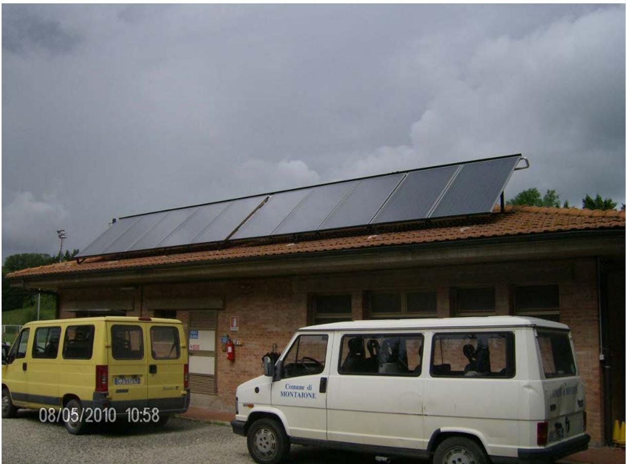
L'impianto solare termico a servizio dell'asilo nido Comunale "IL CERBIATTO" presenta invece una potenza pari a kWp 2,50. Ed è accoppiato ad una caldaia a condensazione a servizio di un impianto di distribuzione a pavimento a bassa temperatura.
