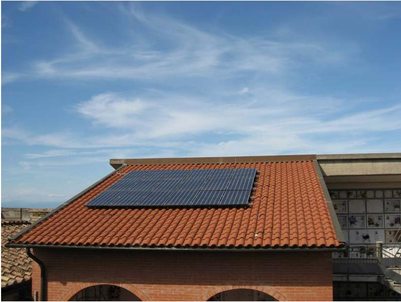
Per il cimitero comunale si registra la realizzazione di un impianto Fotovoltaico della potenza di 4,05 kWp, calcolato per produrre 4.930 kWh/anno. L'impianto gode degli incentivi erogati, DM del 23 Febbraio 2007, oltre che al servizio di Scambio sul Posto e la maggiorazione del 5% per impianti su strutture pubbliche per comuni con meno di 5000 abitanti.
