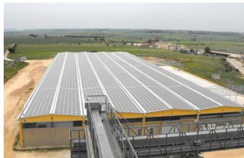
Questa azione prevede l'installazione di impianti fotovoltaici per la produzione elettrica sulle UL esistenti del territorio comunale. Vista la dimensione delle UL, si stima che mediamente ogni UL possa installare 20 kWp sui propri tetti.
