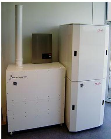
Questa azione prevede di sostituire le caldaie presenti nel territorio comunale con dei motori endotermici in cogenerazione termica ed elettrica. Tale operazione risulta possibile per i condomini con un riscaldamento centralizzato che serve più di 6 alloggi. Con questa azione si stima una produzione di energia elettrica pari al 120% del fabbisogno ad abitazione. Il tasso di implementazione è il seguente:
